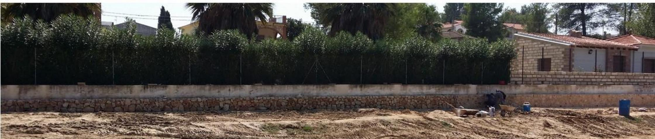
LA ANTIGUA ACEQUIA DE LA MARJAL SE RECUPERA COMO CANAL DE RECOGIDA Y CONDUCCIÓN DE AGUAS PLUVIALES Y SE EJECUTA TAMBIÉN LA SUSTITUCIÓN DE LA ESCALERA Y EL MURO DE MAMPOSTERÍA JUNTO A LA HIGUERA
